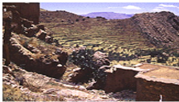
Aménagement d'un espace montagnard Anti atlasique, terrasses mises en culture, habitat situé entre les terroirs cultivés et boisés
