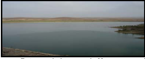
Retenue du barrage de Massa menacée
